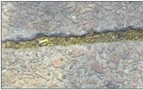
Figura 4: Degrado dei giunti non sigillati
