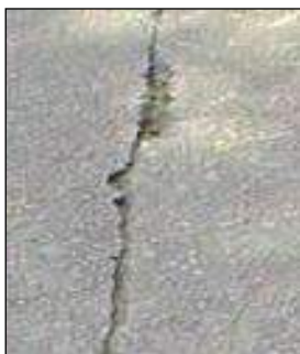
Figura 2: Esempio di fessurazione longitudinale
