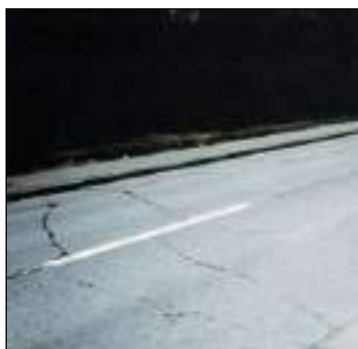
Figura 3: Esempio di fessurazione trasversale
