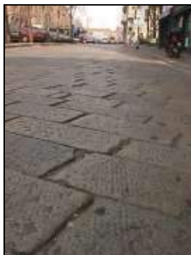
Figura 12: Eccessiva apertura dei giunti non sigillati
