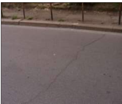
Figura 10: Esempio di fessura trasversale
