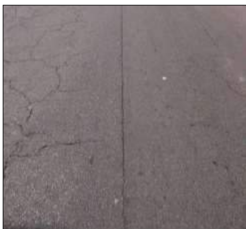
Figura 11: Fessura longitudinale da giunto di stesa.
