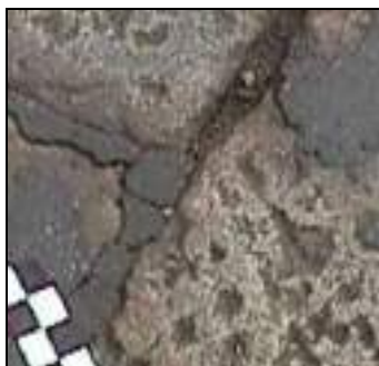
Figura 13: Asportazione di sigillante dai giunti
