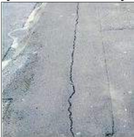
Figura 7: Schema di fessurazione longitudinale
